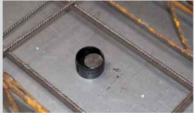
Нижняя часть спринклерного соединительного элемента арт. № 4114180 для видимого спринклера. Крепление магнитом.
