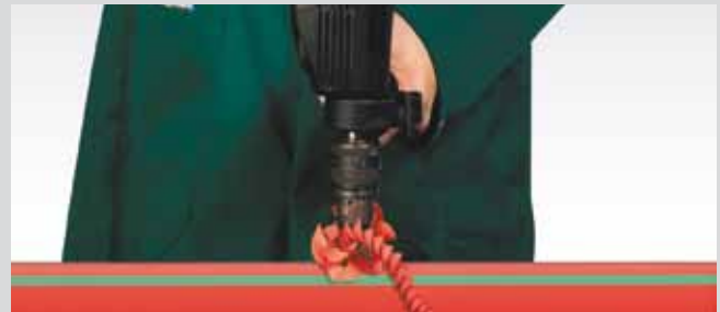
Просварливание отверстия в стенке трубы.
