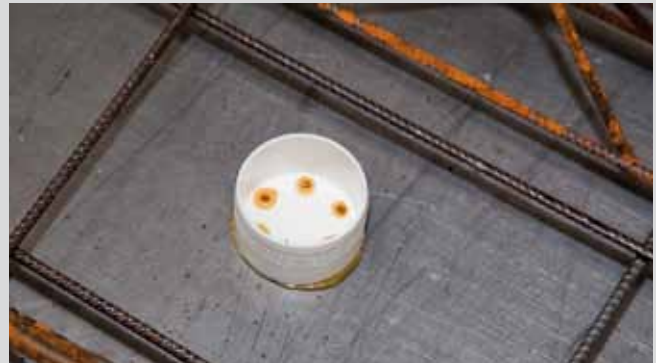
Нижняя часть спринклерного соединительного элемента арт. № 4114190 для скрытого спринклера. Крепление горячим клеем.
